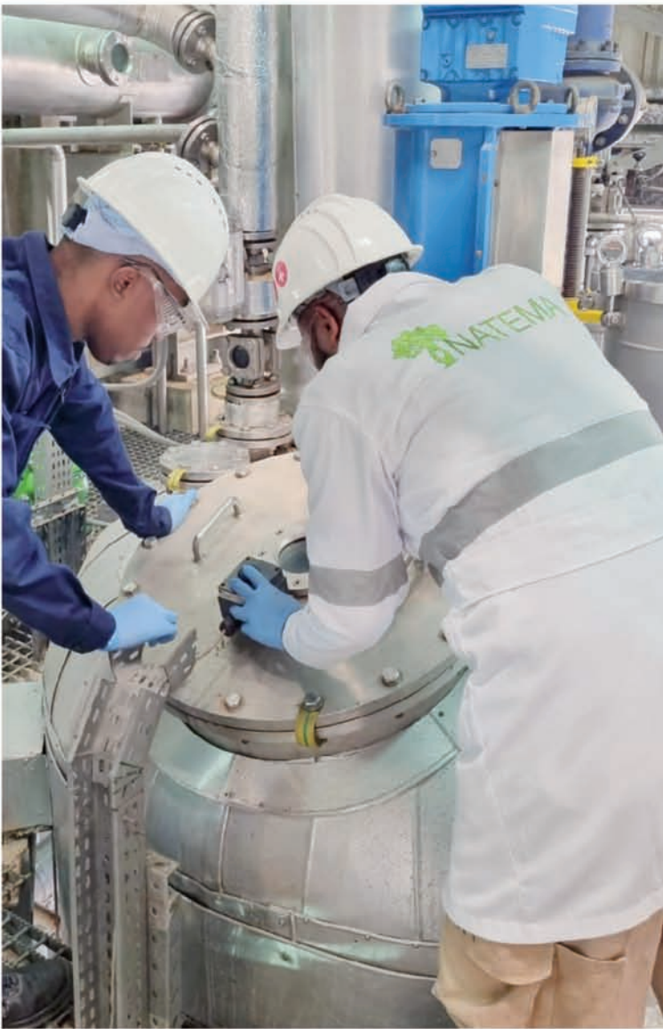
▲ Colonne de rectification
