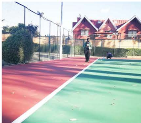
Revêtement Sol Sportif chantier sur TANA
